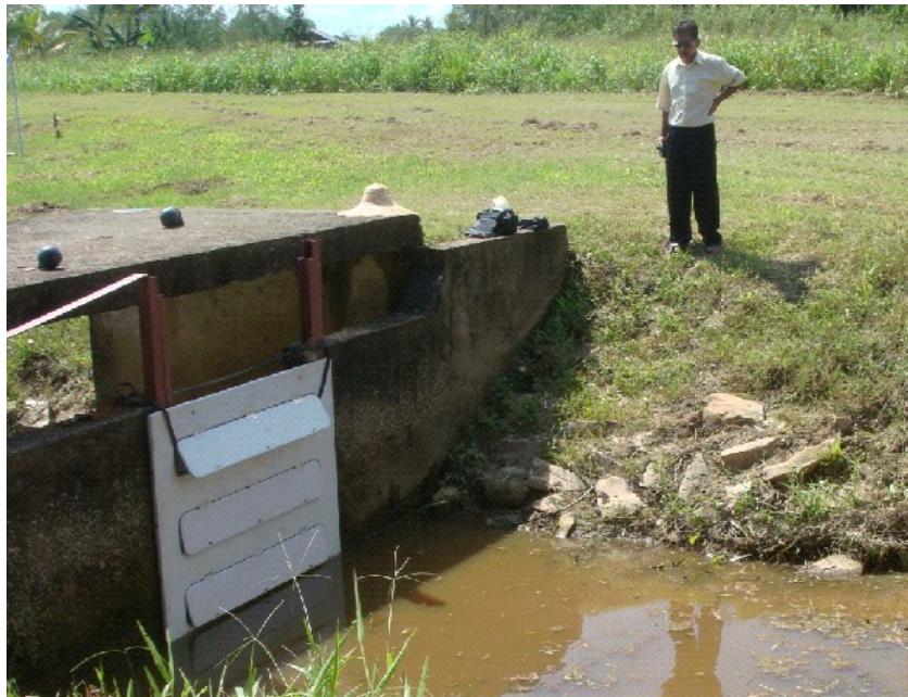
Papan Injap 2R di pasang di Struktur 'Check Gate'
