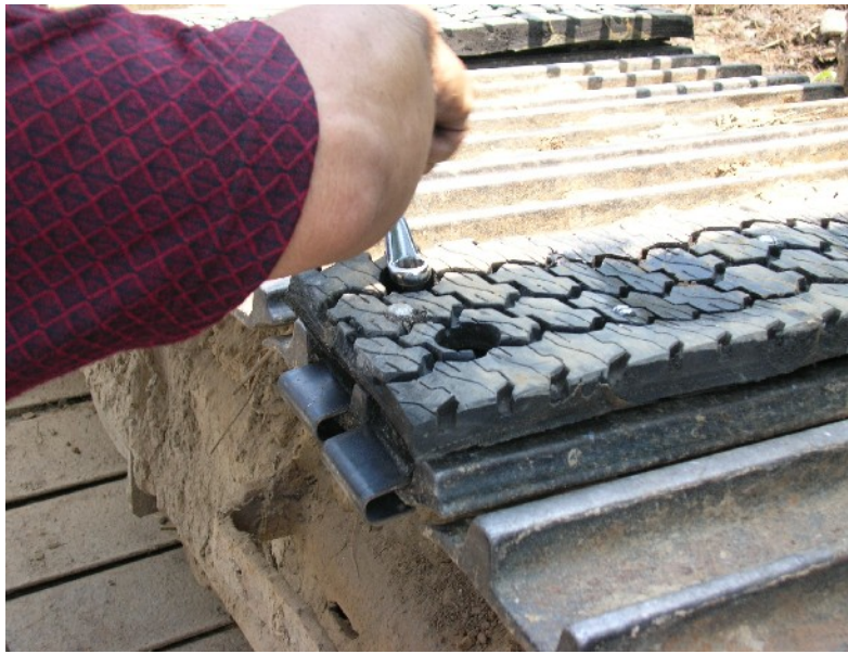
Kepingan Ex-MAT sedang dipasang pada trek jengkaut
